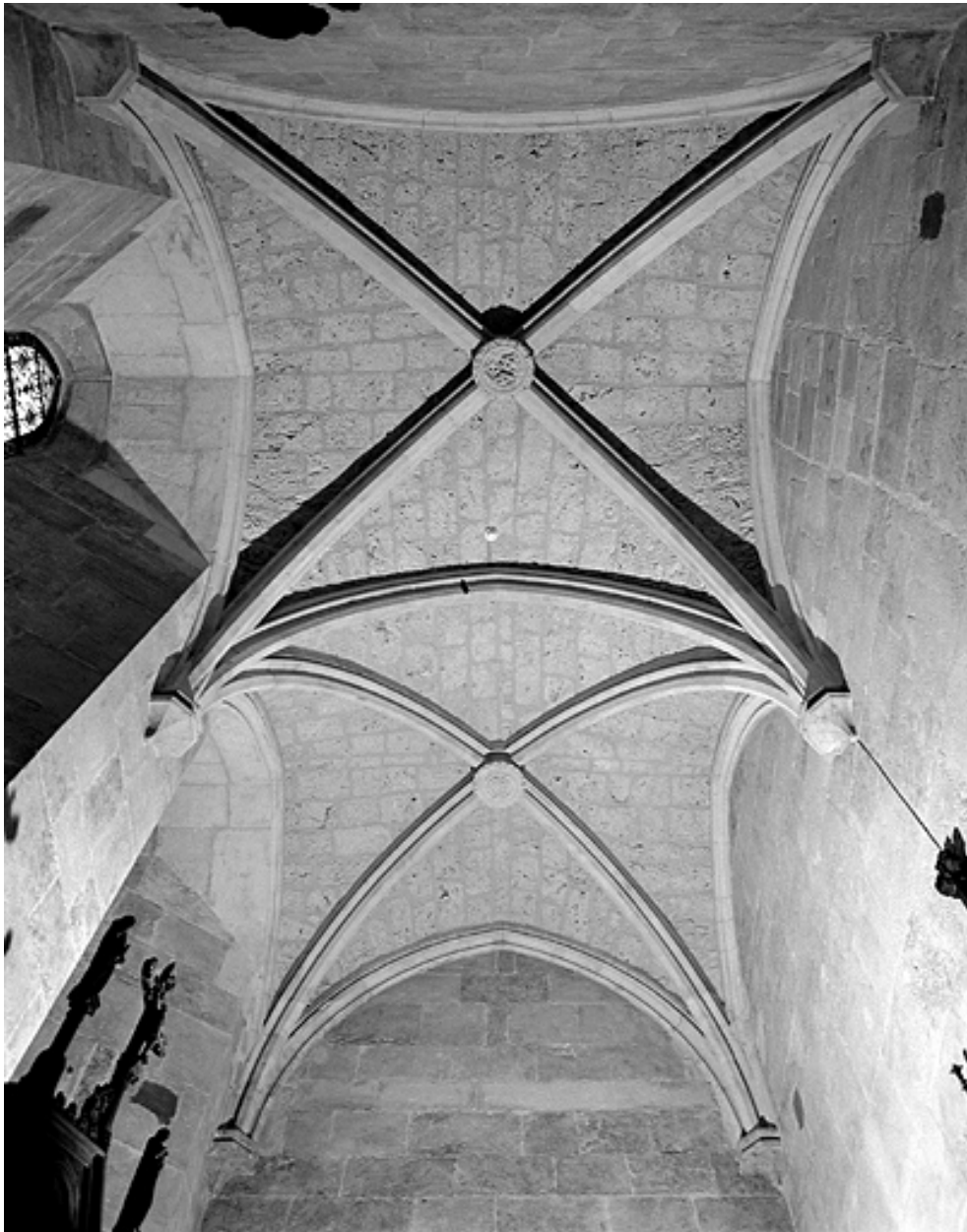
Voûtes de l'ancienne sacristie.
