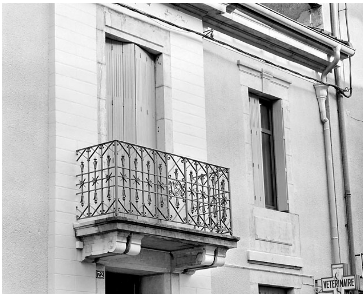
Façade antérieure : balcon et baies de l'étage.
