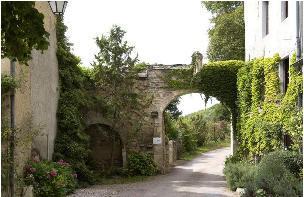
Vestige de la porterie ouest : porte cochère et porte piétonne murée (face est).
