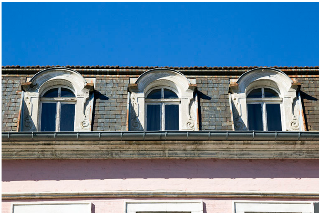
Façade antérieure : lucarnes.
