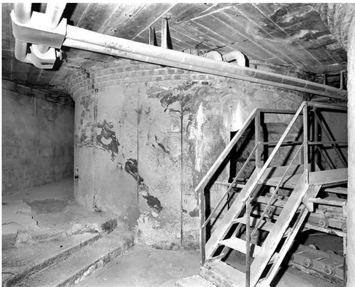
Soubassement d'un four à surcuit.
