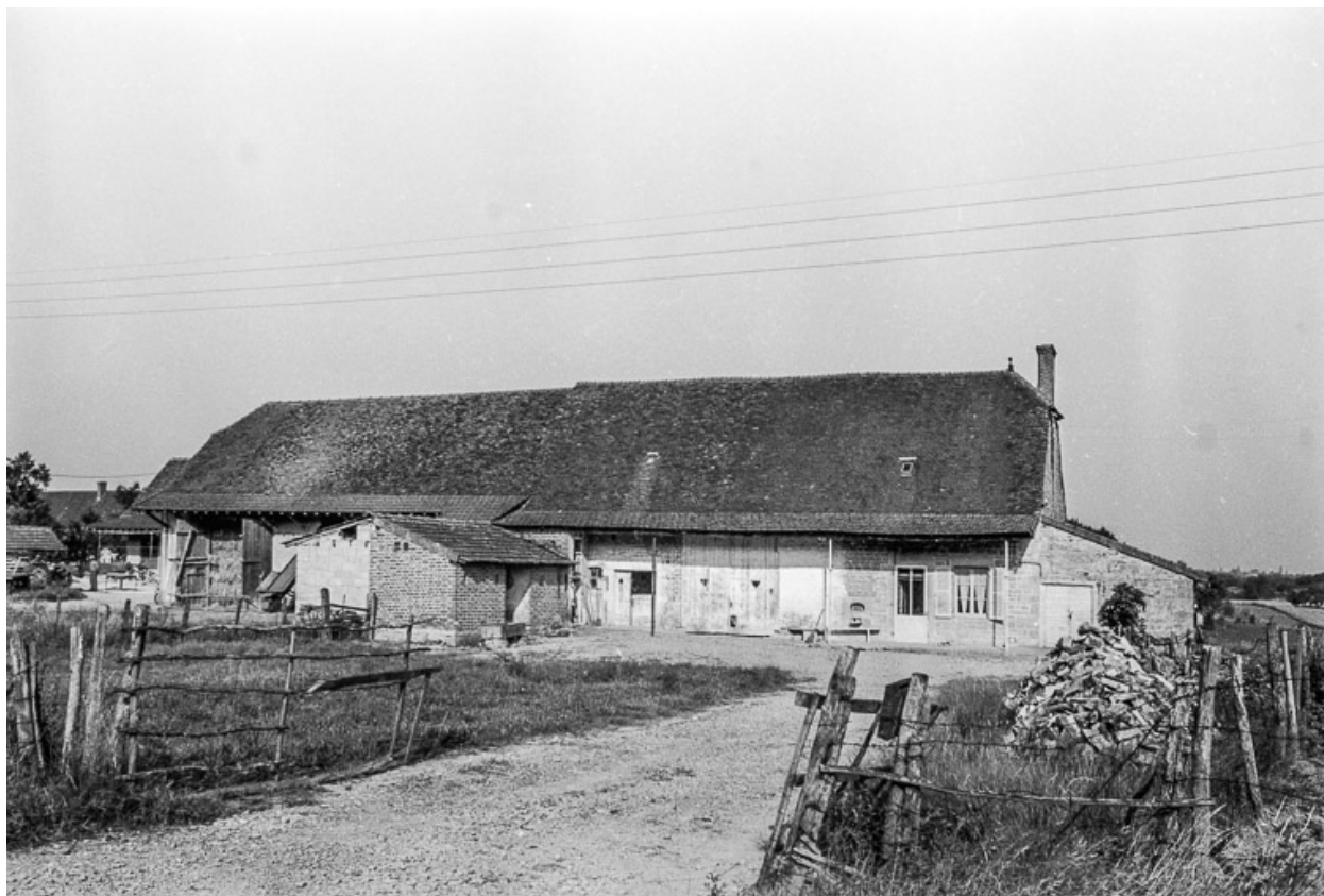
ferme cadastrée 1956 A2 460 : vue générale.
