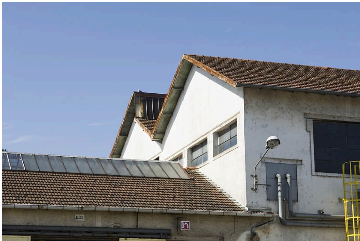
Toiture d'un magasin industriel.
