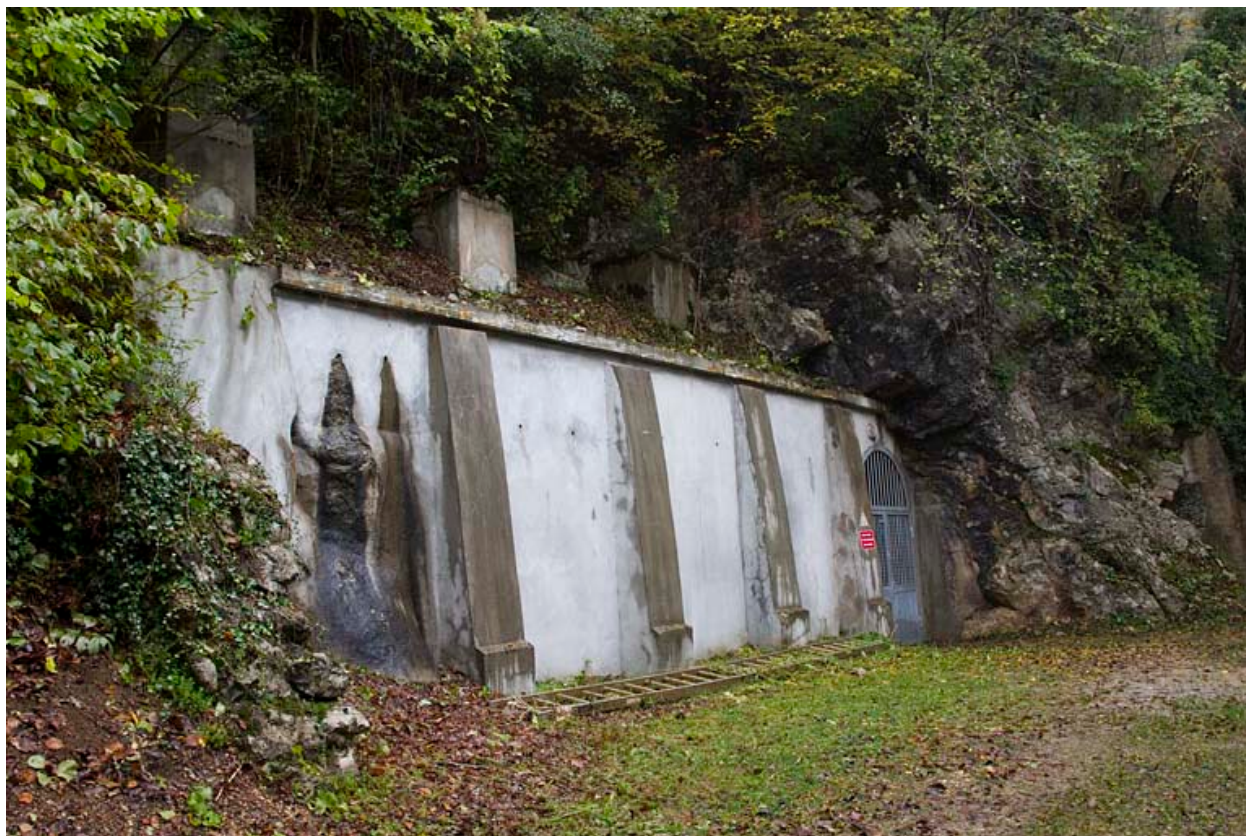
Tunnel d'amenée d'eau : tête aval.
