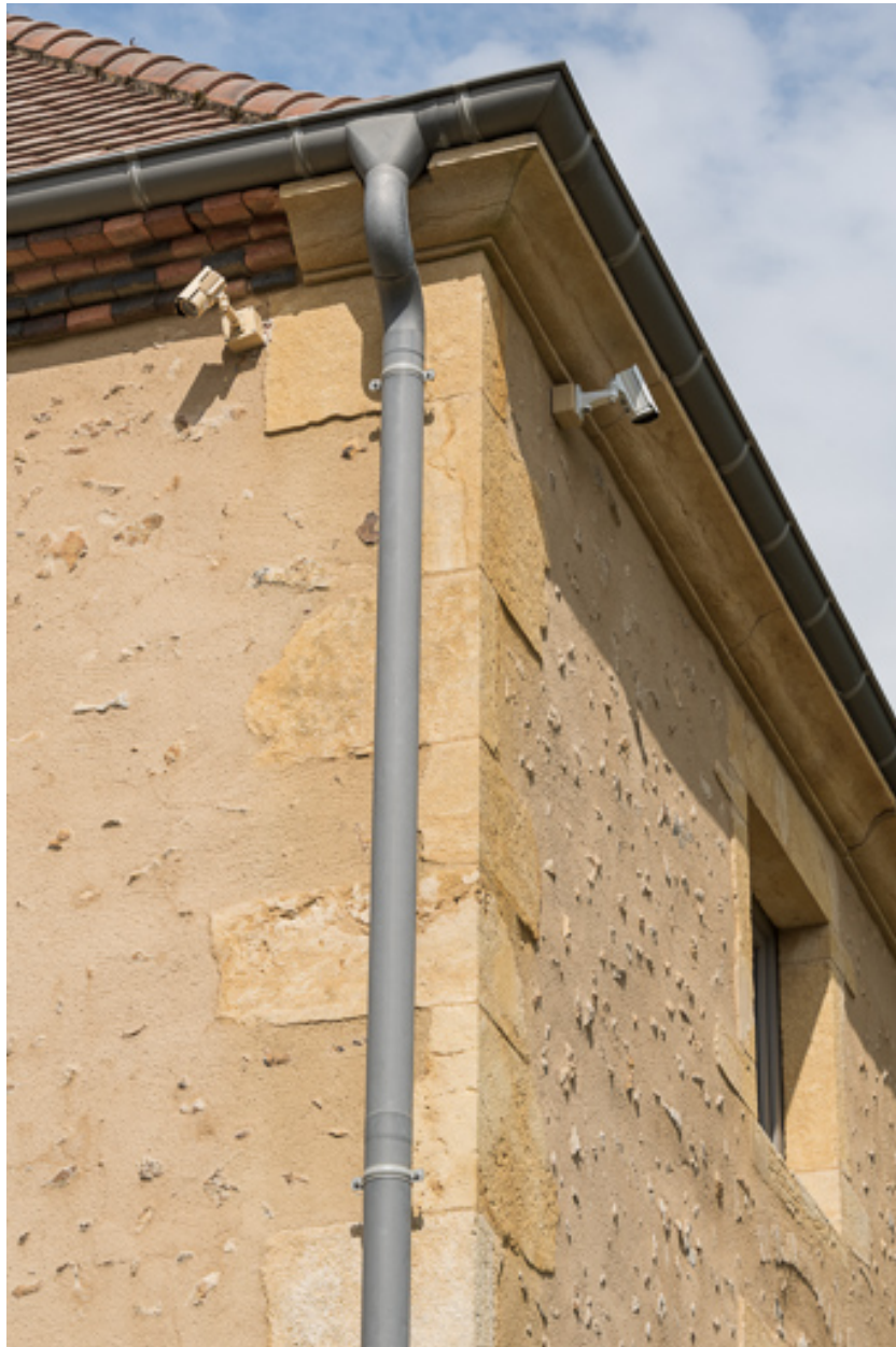
Détail de la corniche en pierre calcaire sur la façade antérieure de la maison
