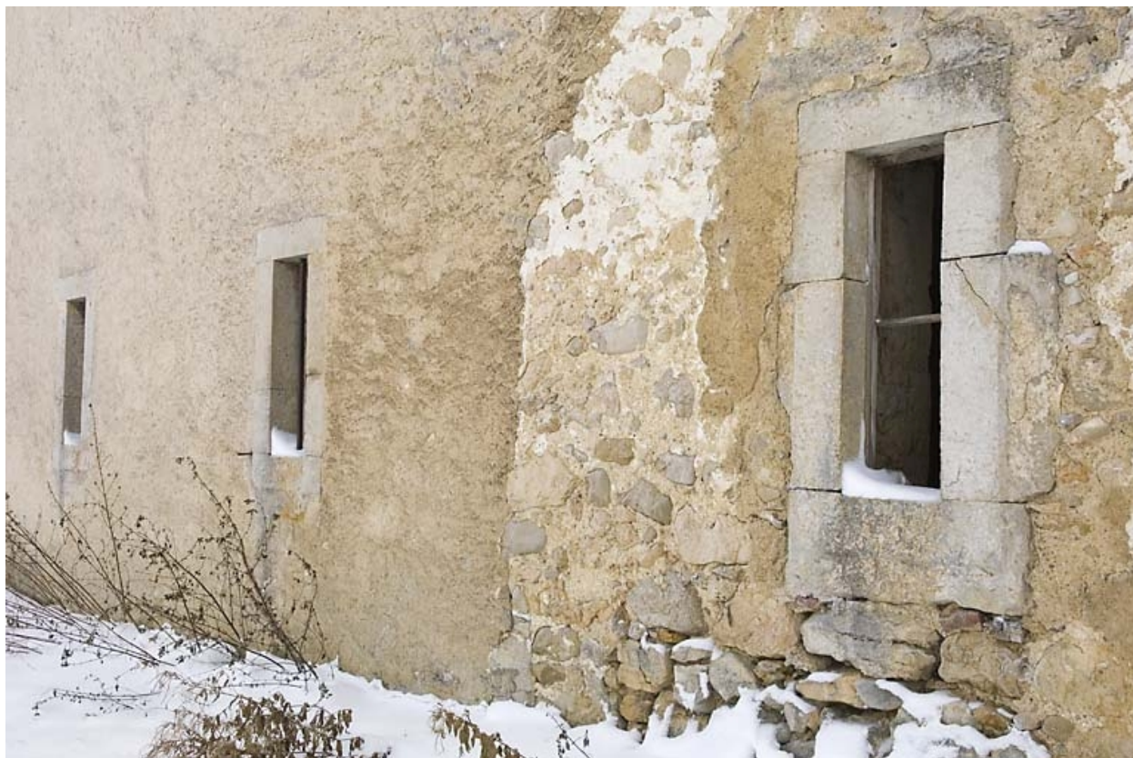
Façade latérale gauche : baies fromagères.
