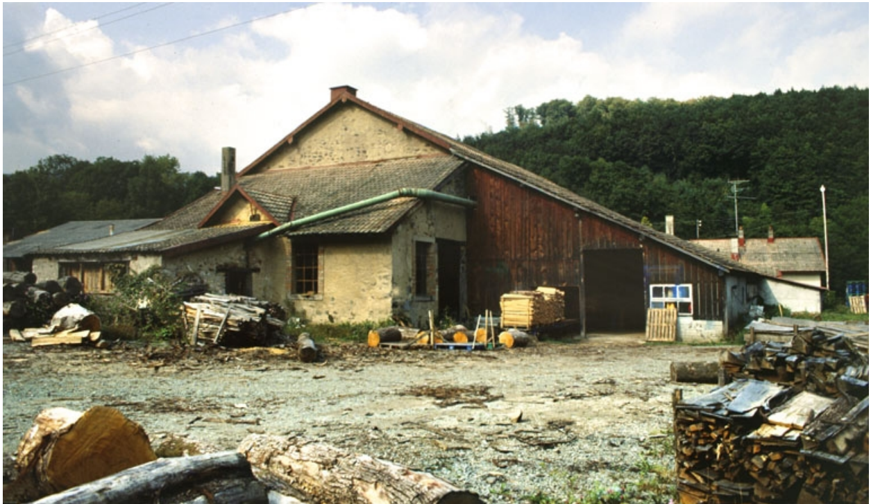
L'atelier de fabrication depuis le sud.
