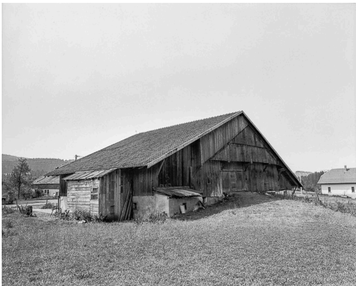
Ferme située au lieu-dit Colombière, cadastrée AB 75 : façade postérieure.
