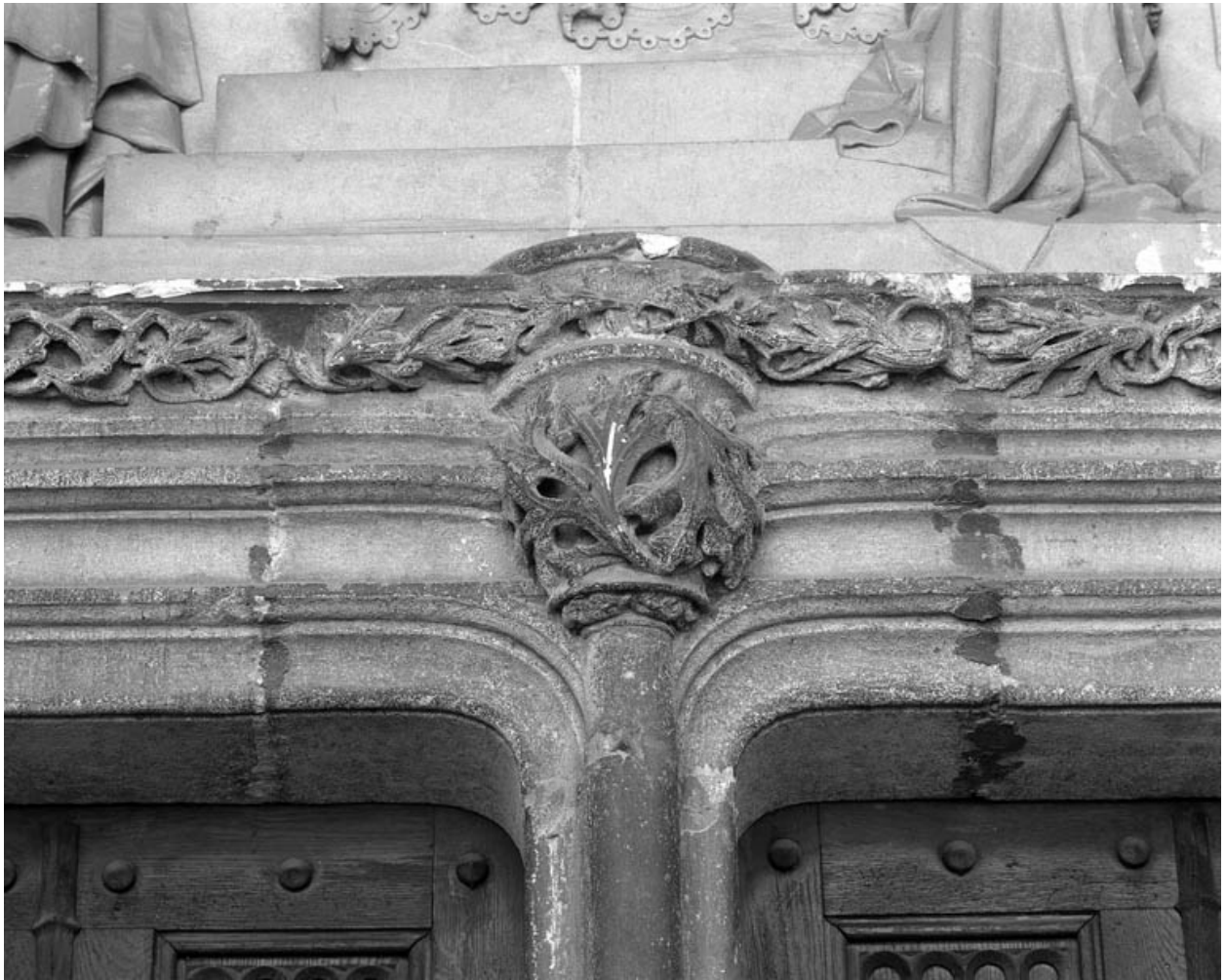
Façade antérieure, portail : porte centrale, détail de la partie supérieure du pilier central.
