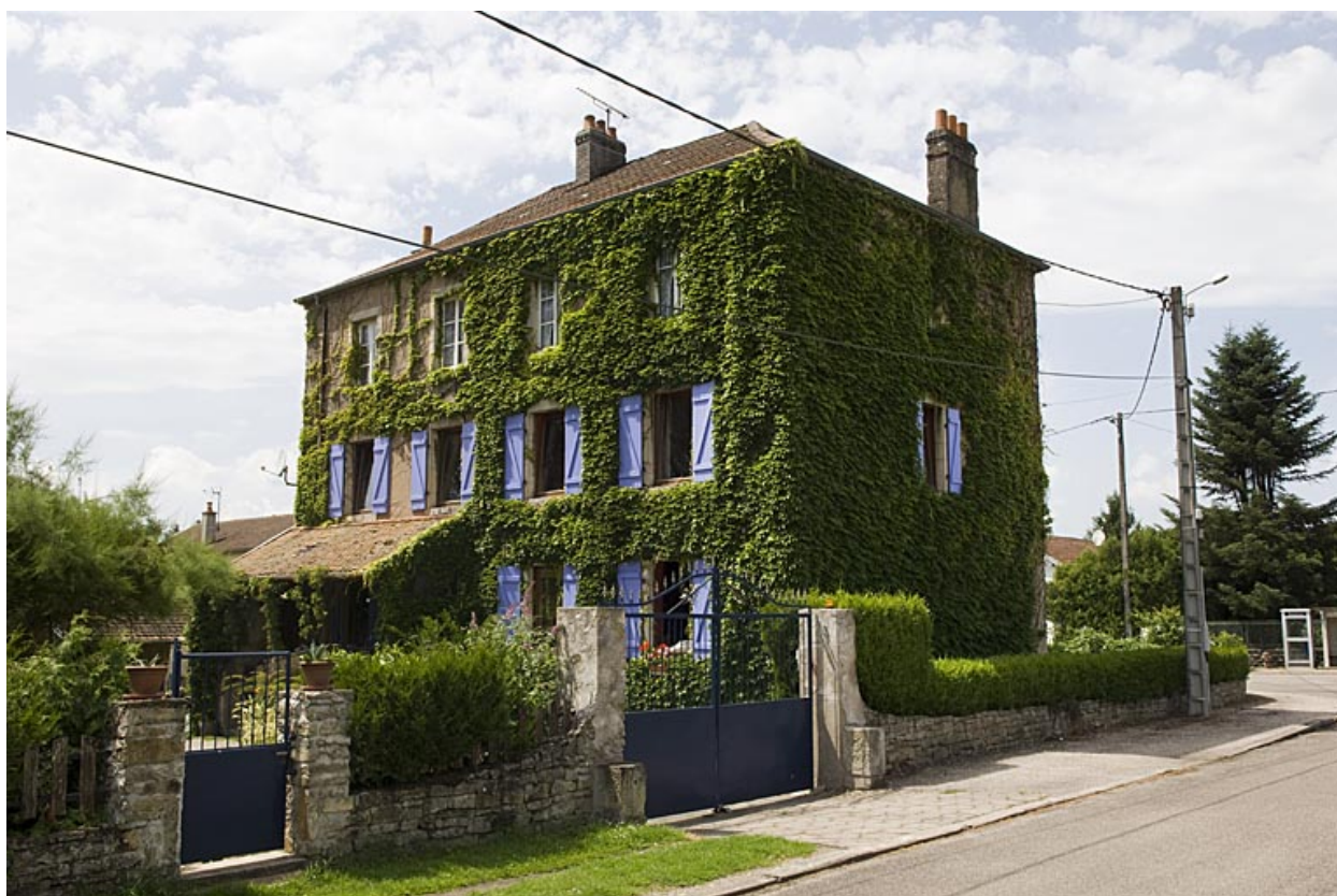
Façade postérieure, vue de trois quarts droit.
