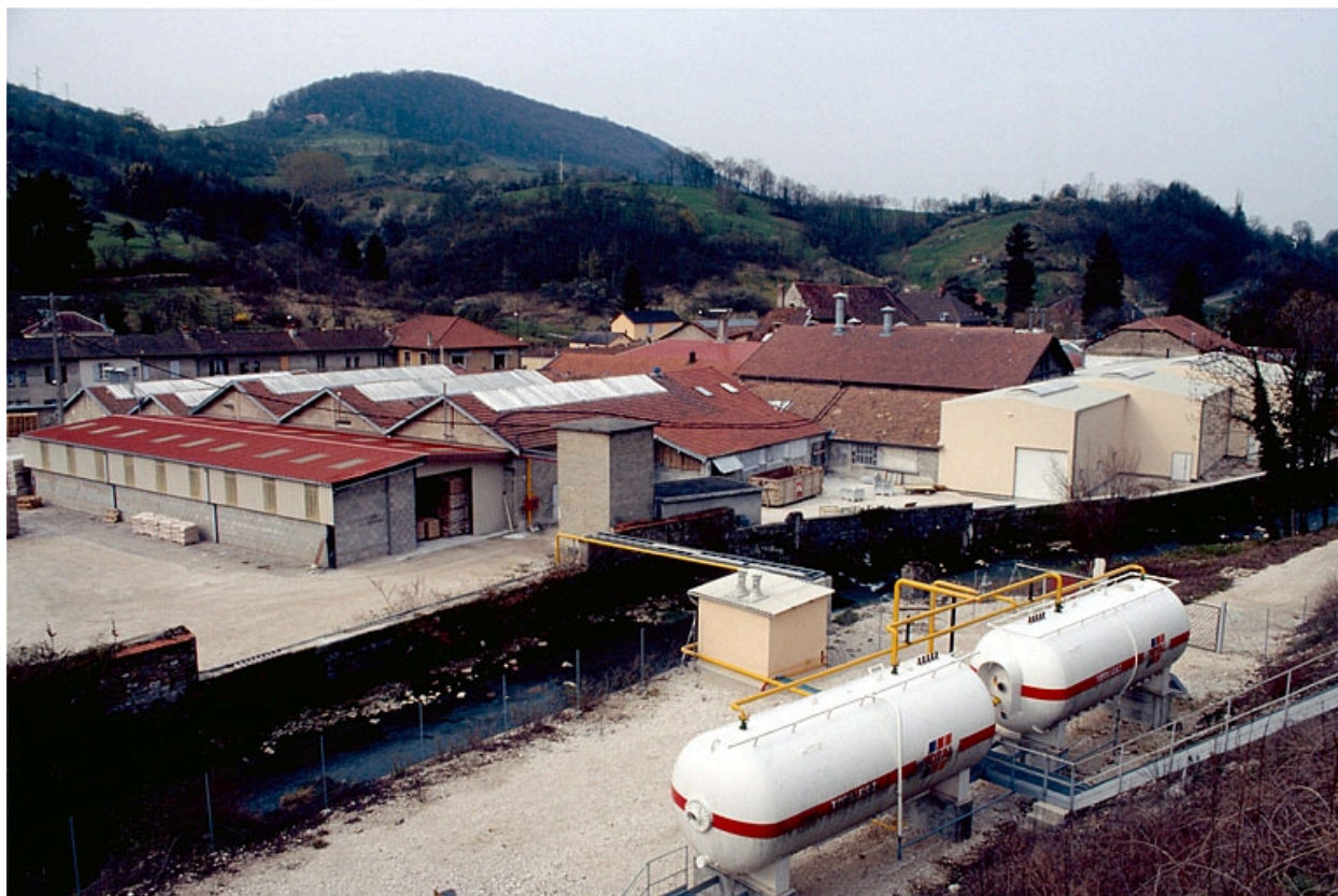
Faïencerie des Capucins, Salins-les-Bains.
