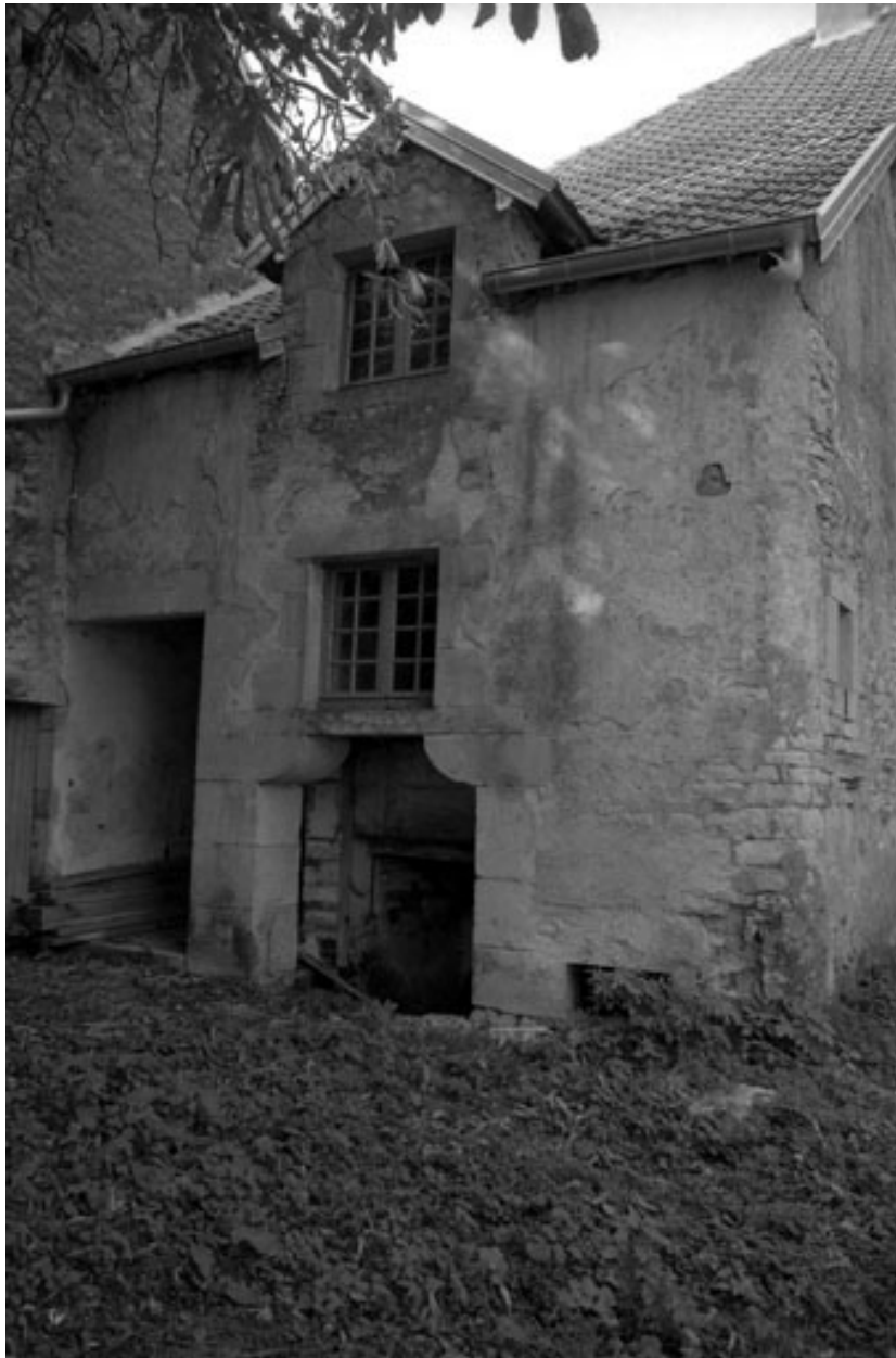
Partie gauche de la ferme.
