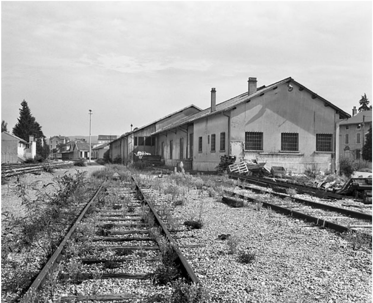
Entrepôts, depuis le sud-ouest (côté La Cluse).
