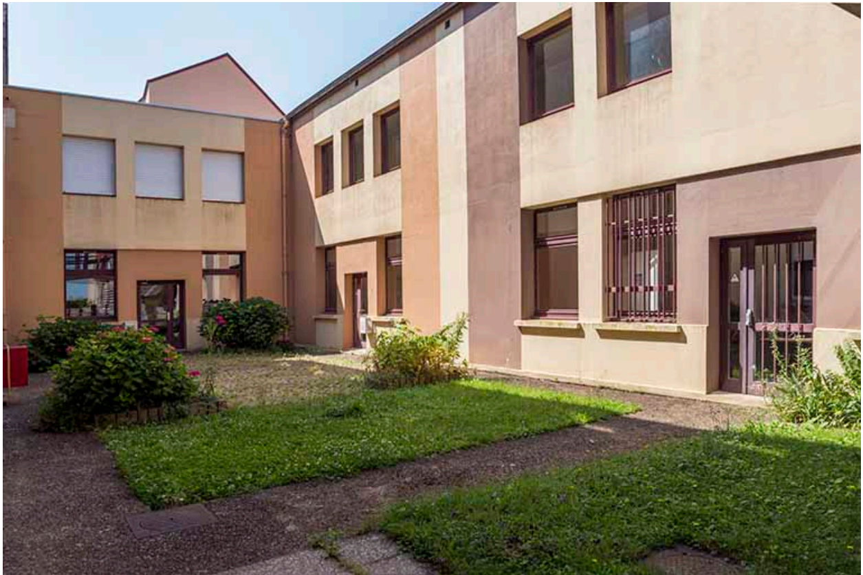
Détail jardin intérieur au sud-ouest de la barre d'externat ouest.
