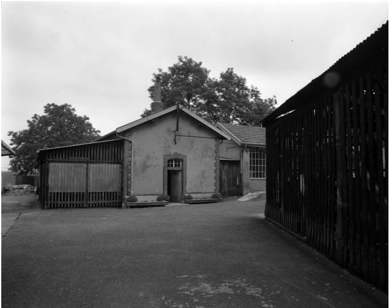
Extension de la caserne : bâtiments annexes, détail de la partie droite.
