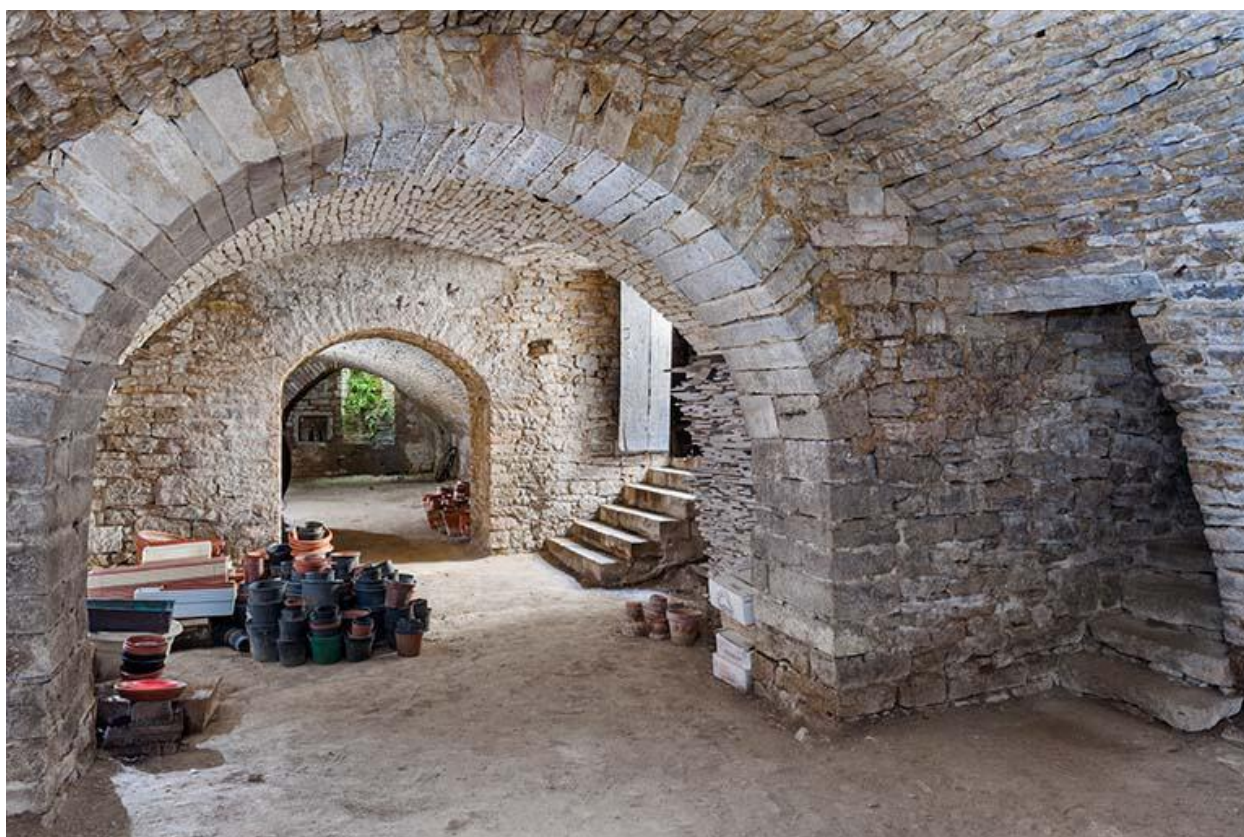
Vue générale de la cave
