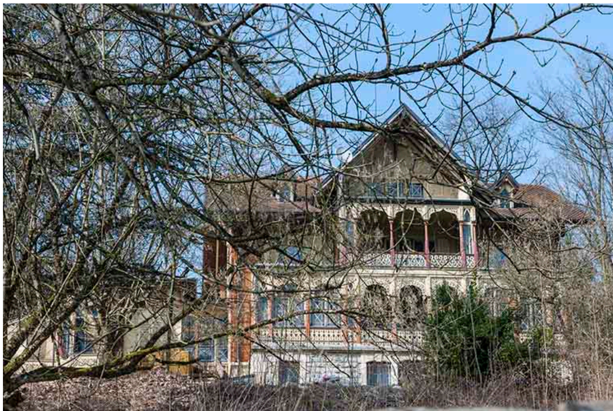
Façade sud du logement patronal.
