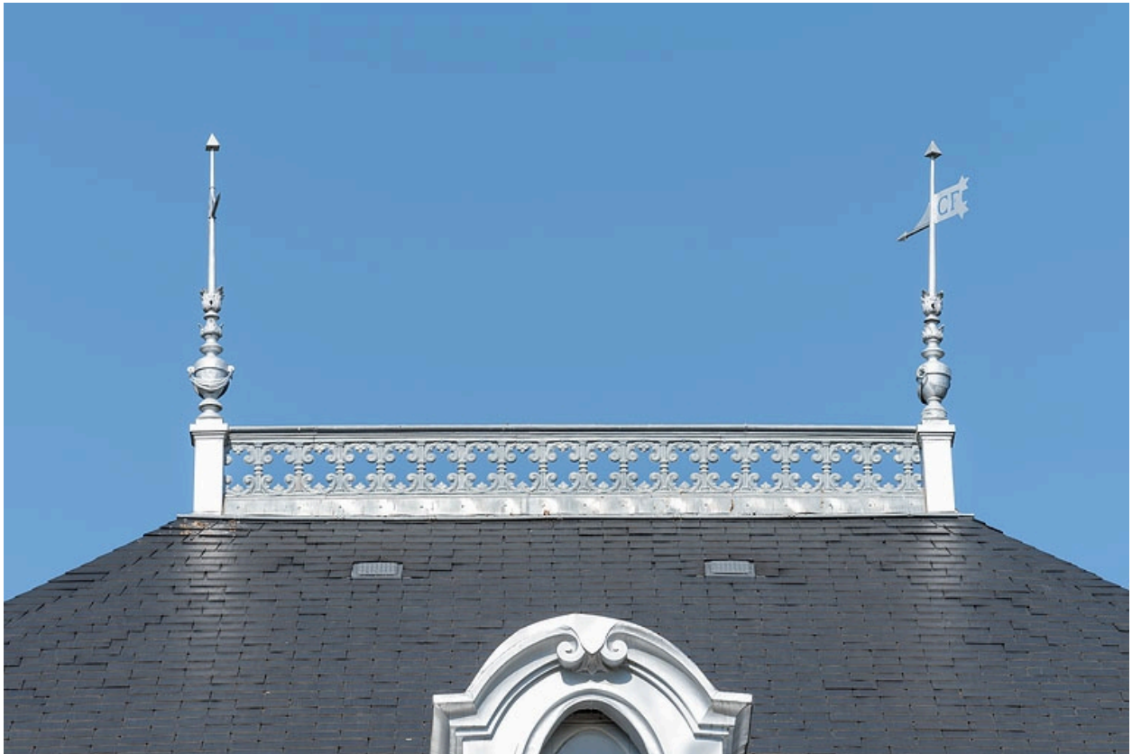
Crête et épis de faîtage.
