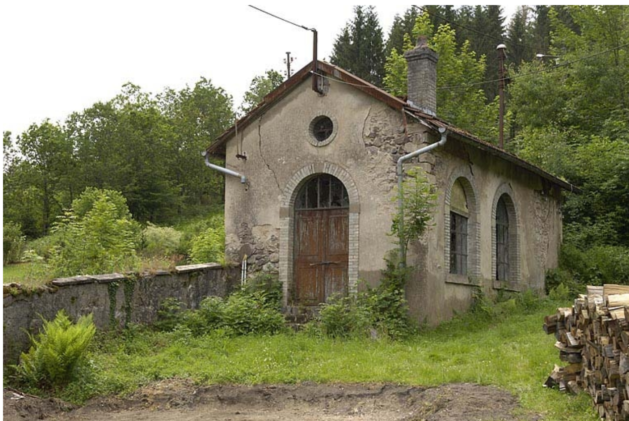
Ancienne centrale hydroélectrique.
