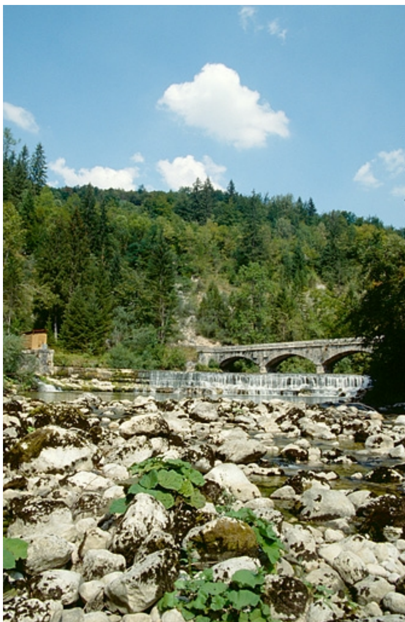
Le barrage, vu de l'aval.
