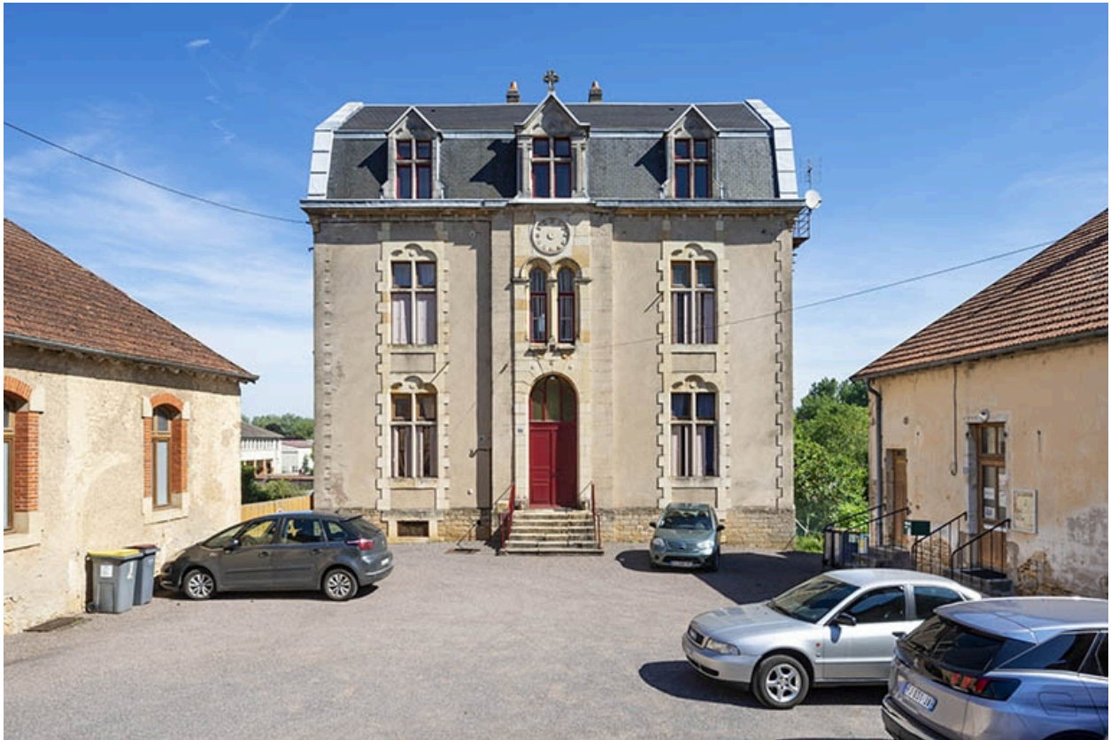
La façade du bâtiment principal.
