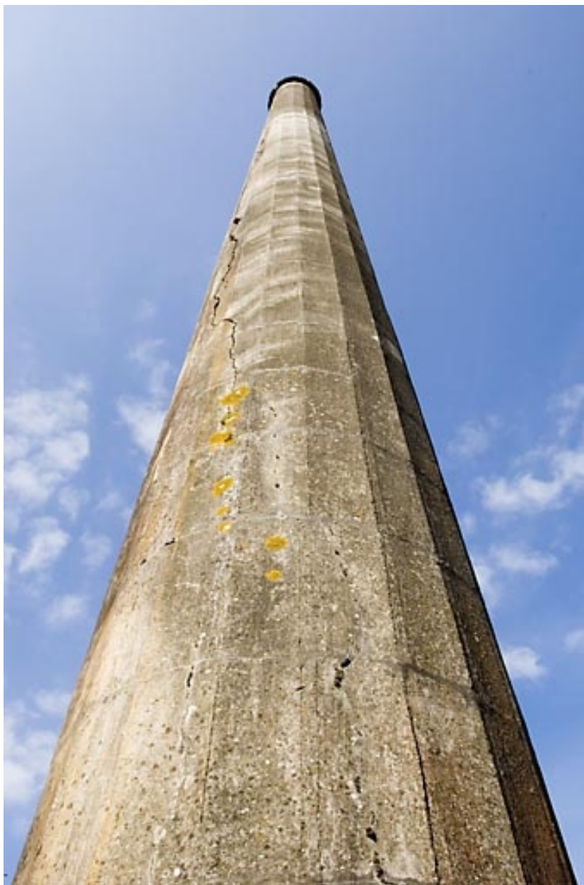
Cheminée vue en contre-plongée (1).
