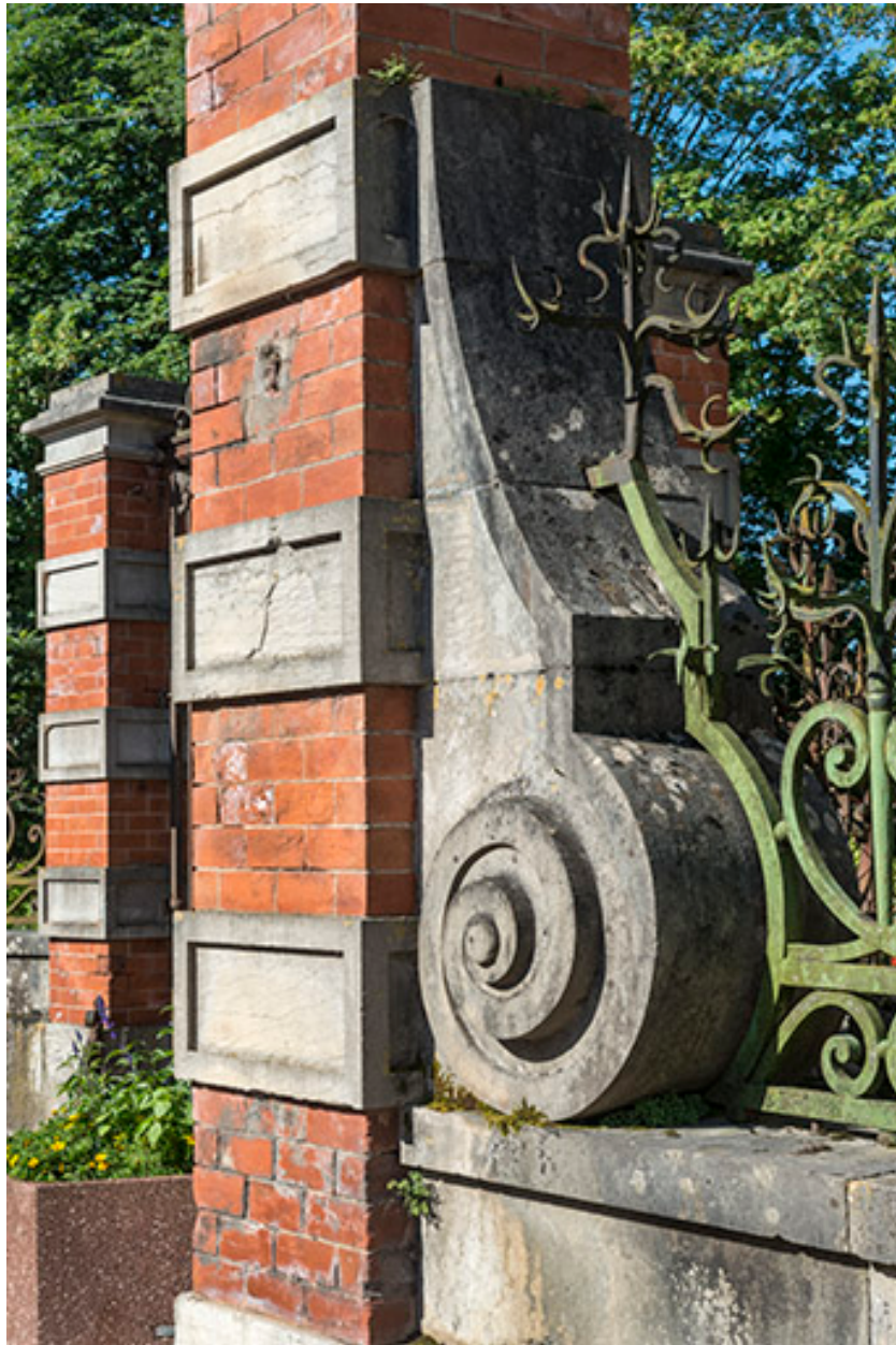
Clôture (grille) sur la rue Armand Paulmard.
