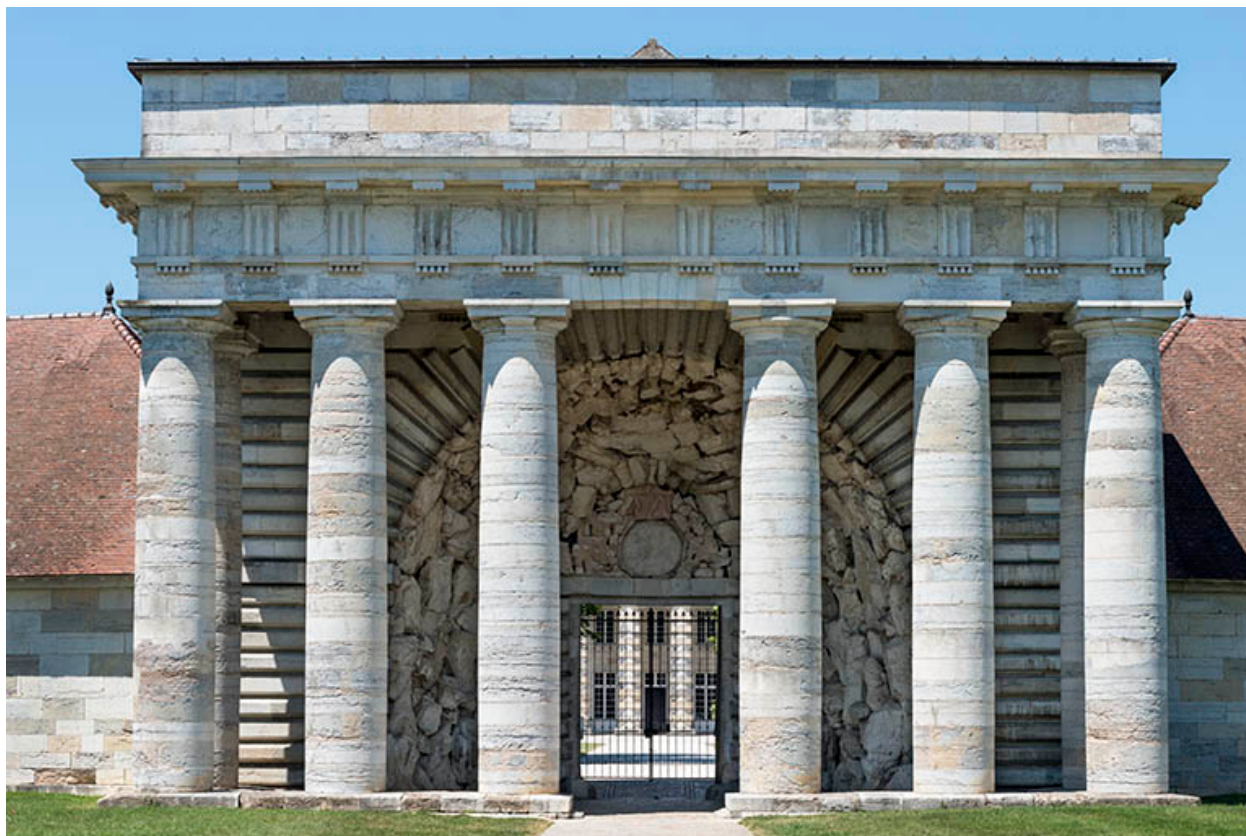
Vue axiale du portique d'entrée.
