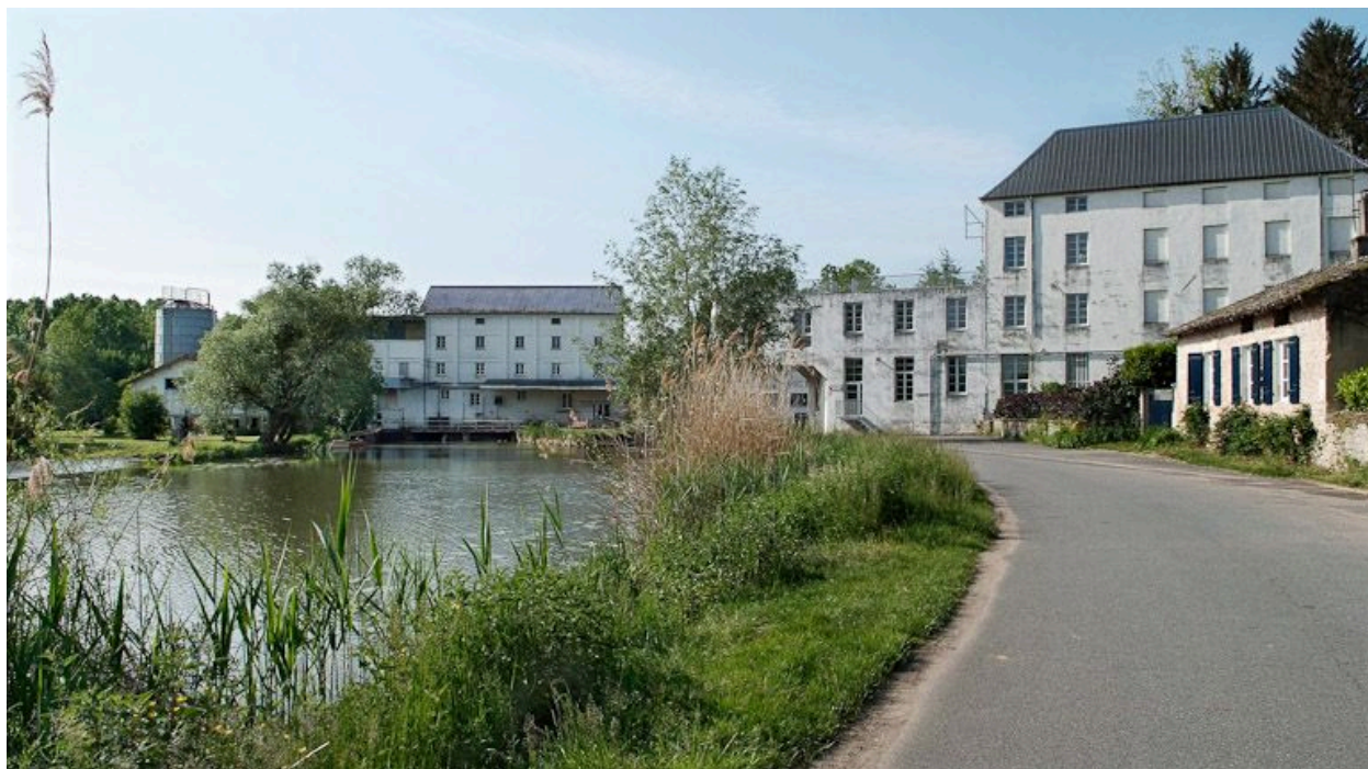
Le moulin vu d'amont depuis la route qui y mène.
