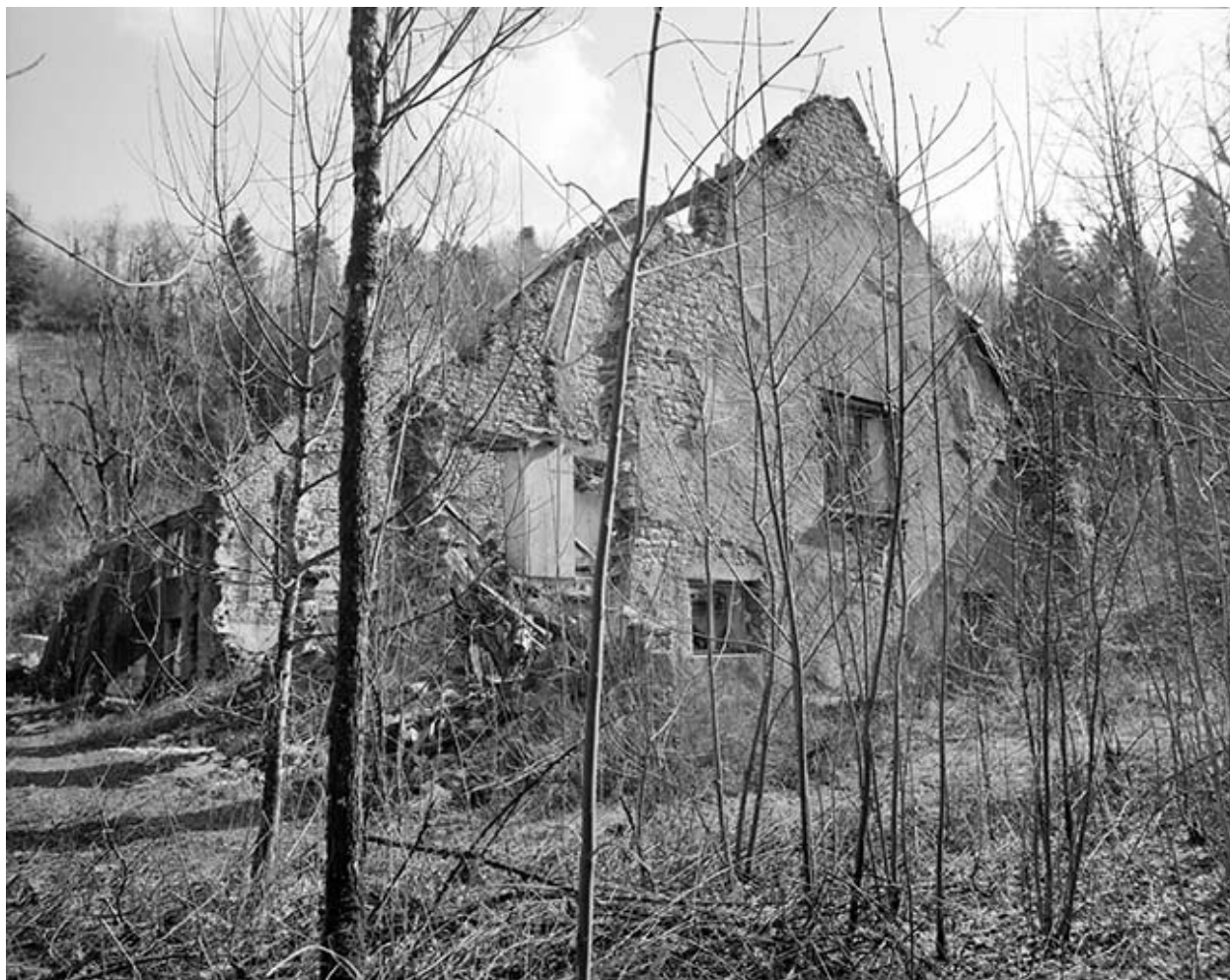
Pignon ouest du logement patronal.
