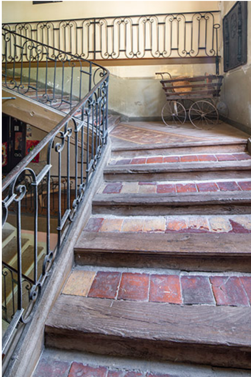
Volée d'escalier entre le premier et le second étage.
