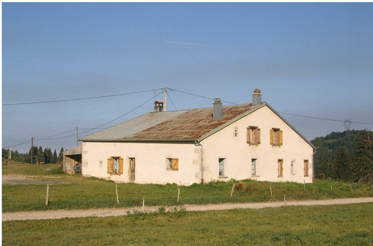
Façade antérieure et face droite.
