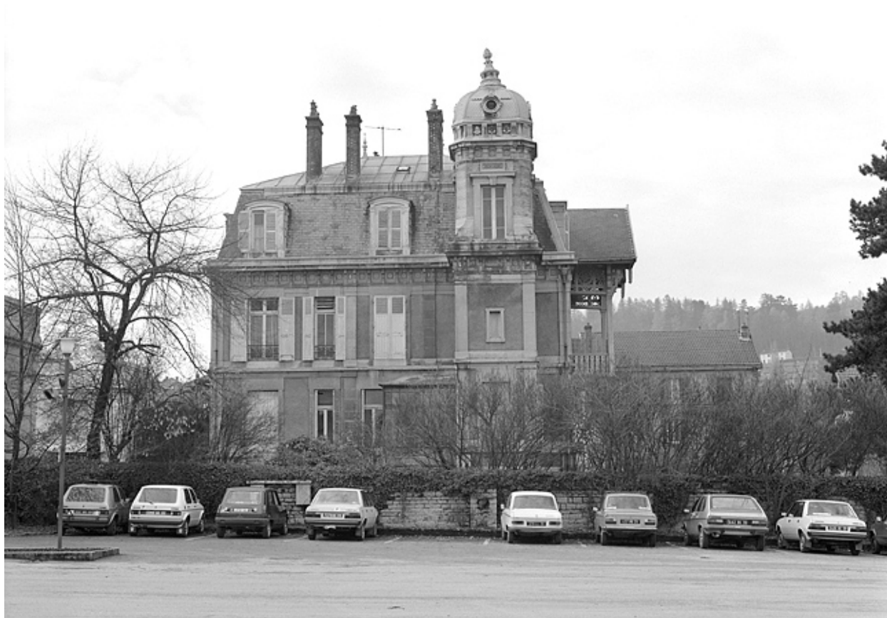
Façade latérale droite.
