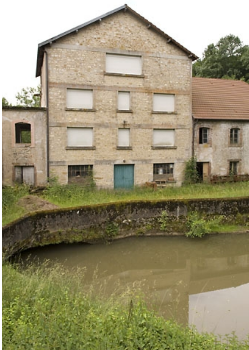
Façade de l'atelier de fabrication.
