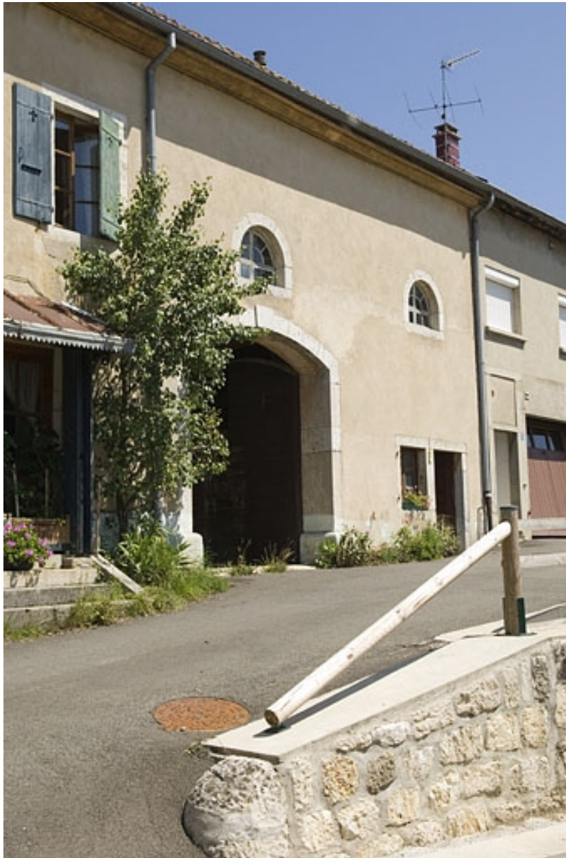
Vue de trois quart rapprochée.
