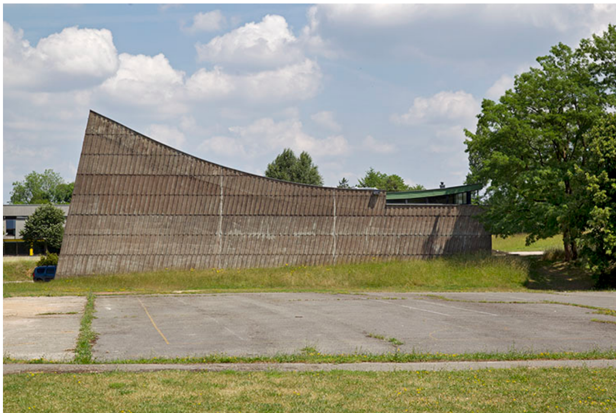
Flanc ouest du gymnase.
