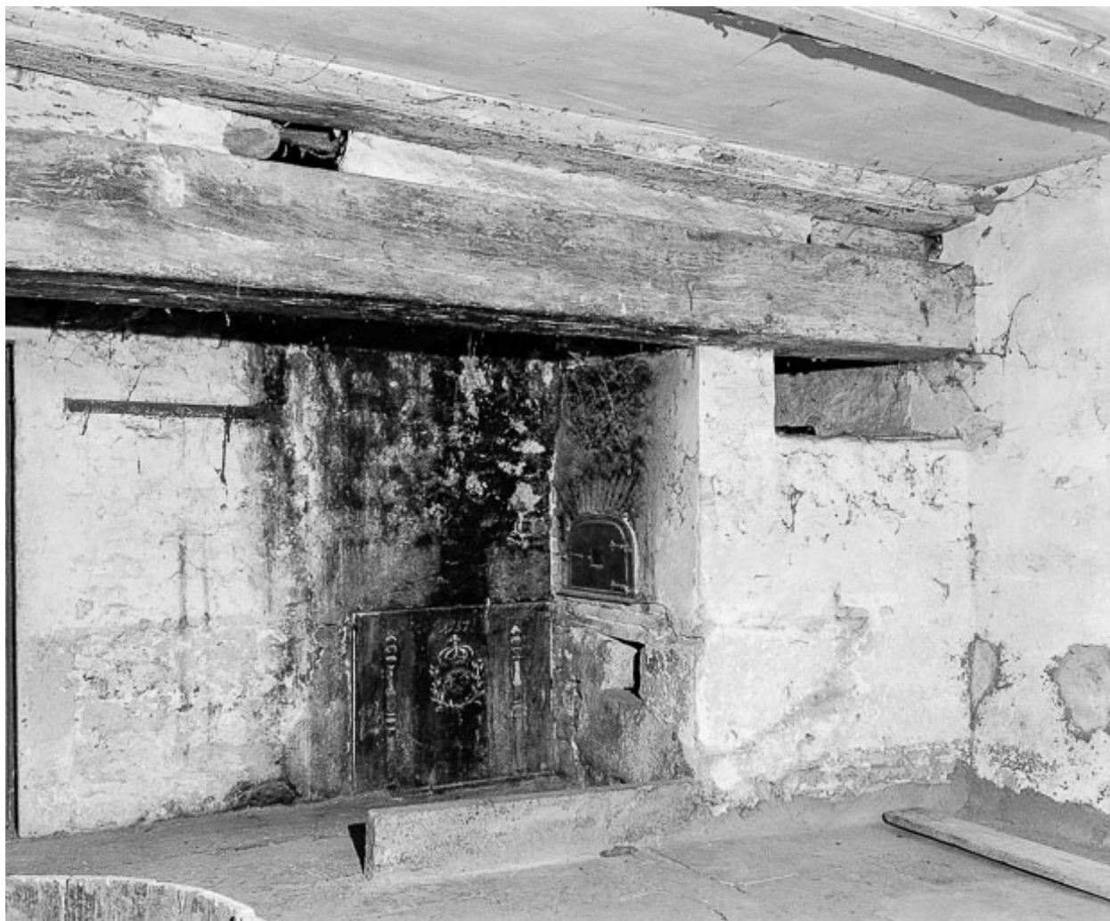
Intérieur : cheminée et four de la cuisine.
