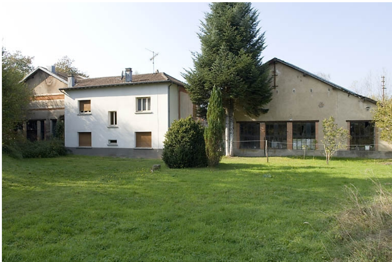
Façades postérieures depuis l'est.
