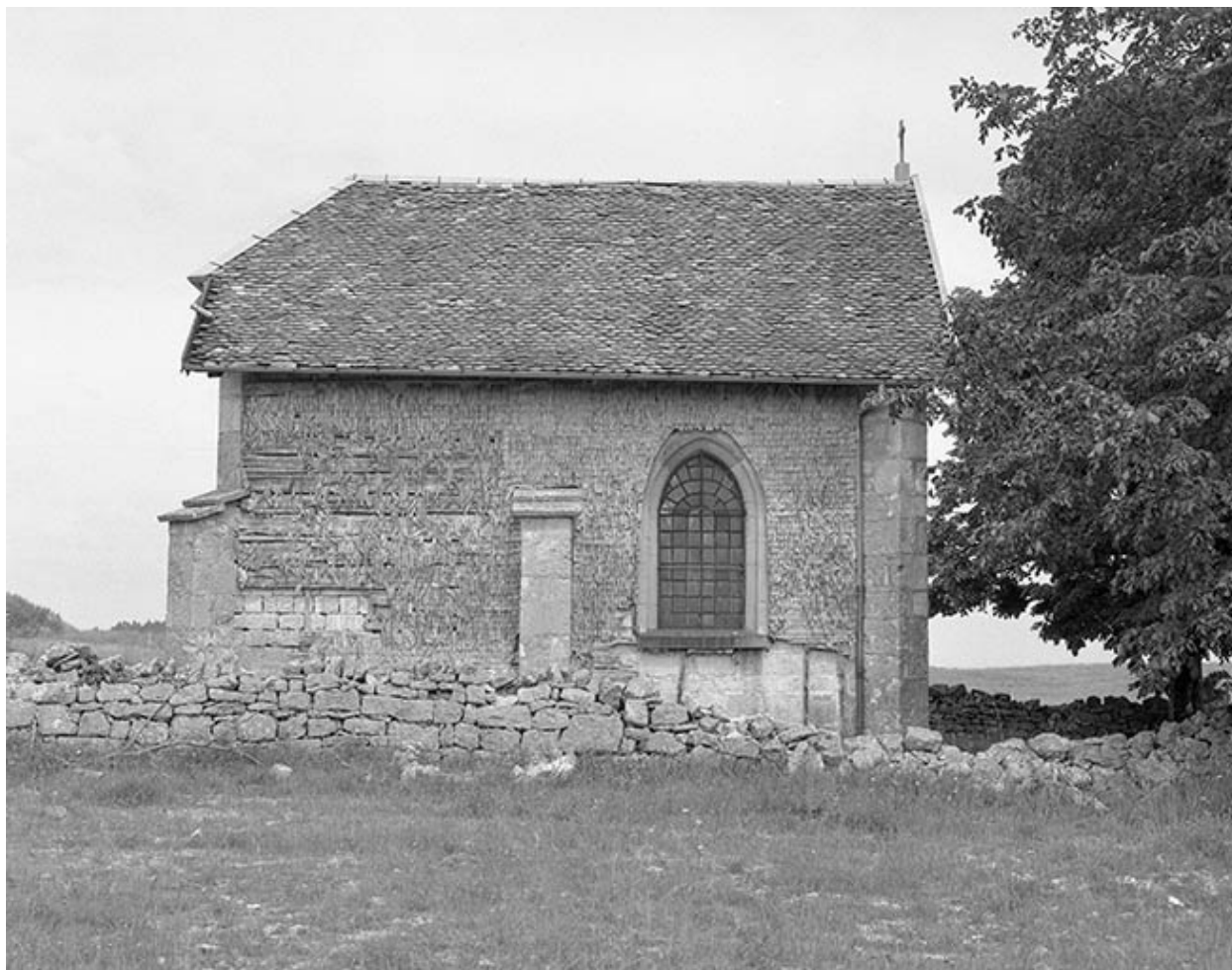
Façade latérale nord.
