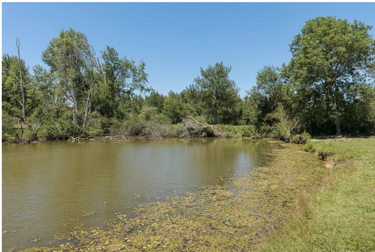
Vue de la digue.
