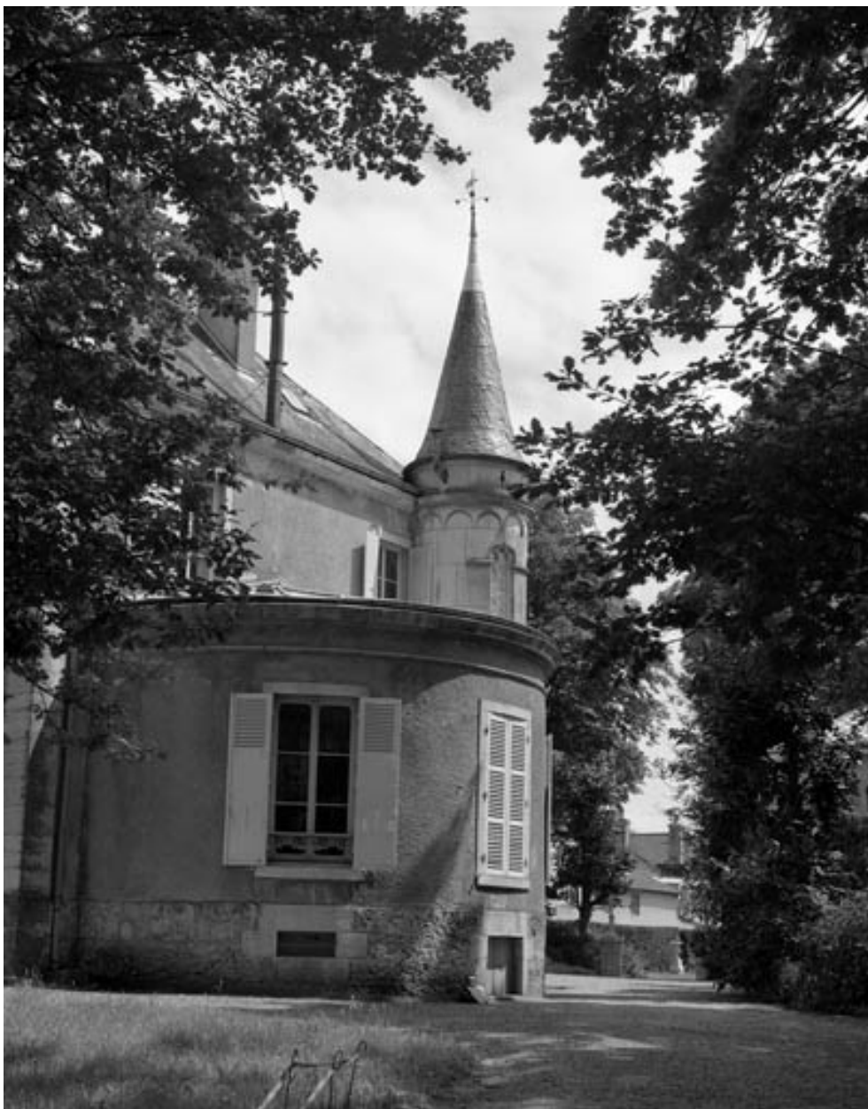
Façade latérale gauche de l'habitation.
