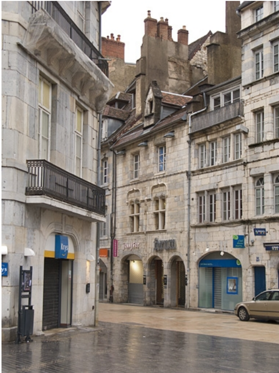
Façade antérieure du 15 Grande Rue : vue éloignée de trois quarts droit.
