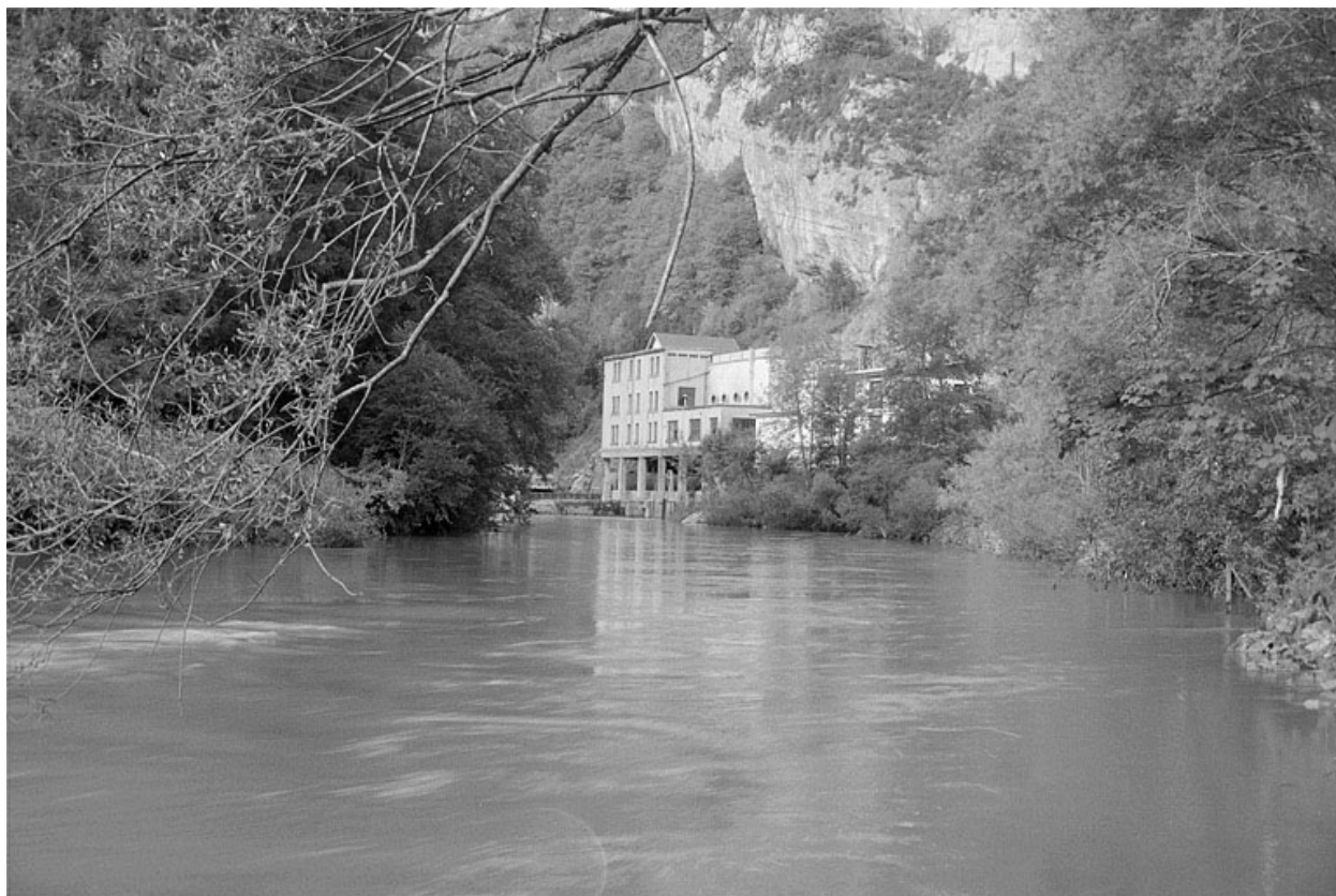
Vue d'ensemble, depuis l'aval.
