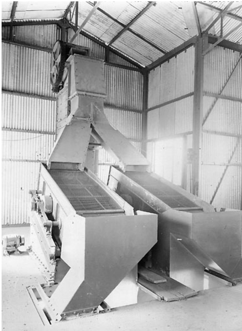
Atelier de concassage. Cribles vibrants.
