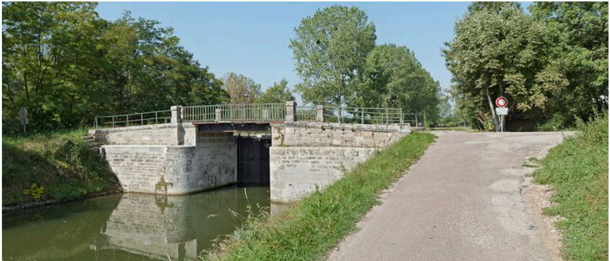
Vue du pont sur écluse depuis l'aval.
