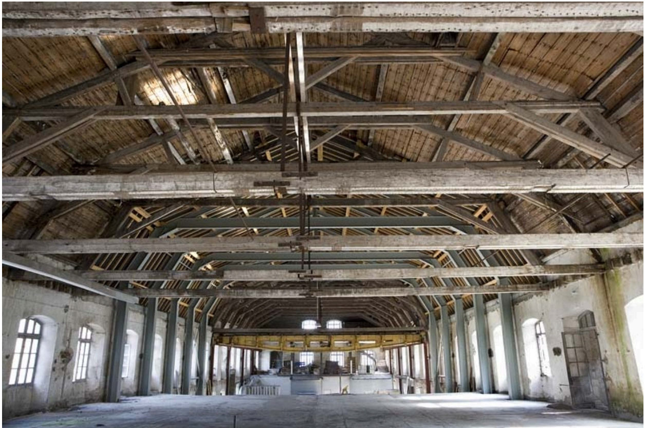
Vue rapprochée de la charpente, depuis le premier étage.
