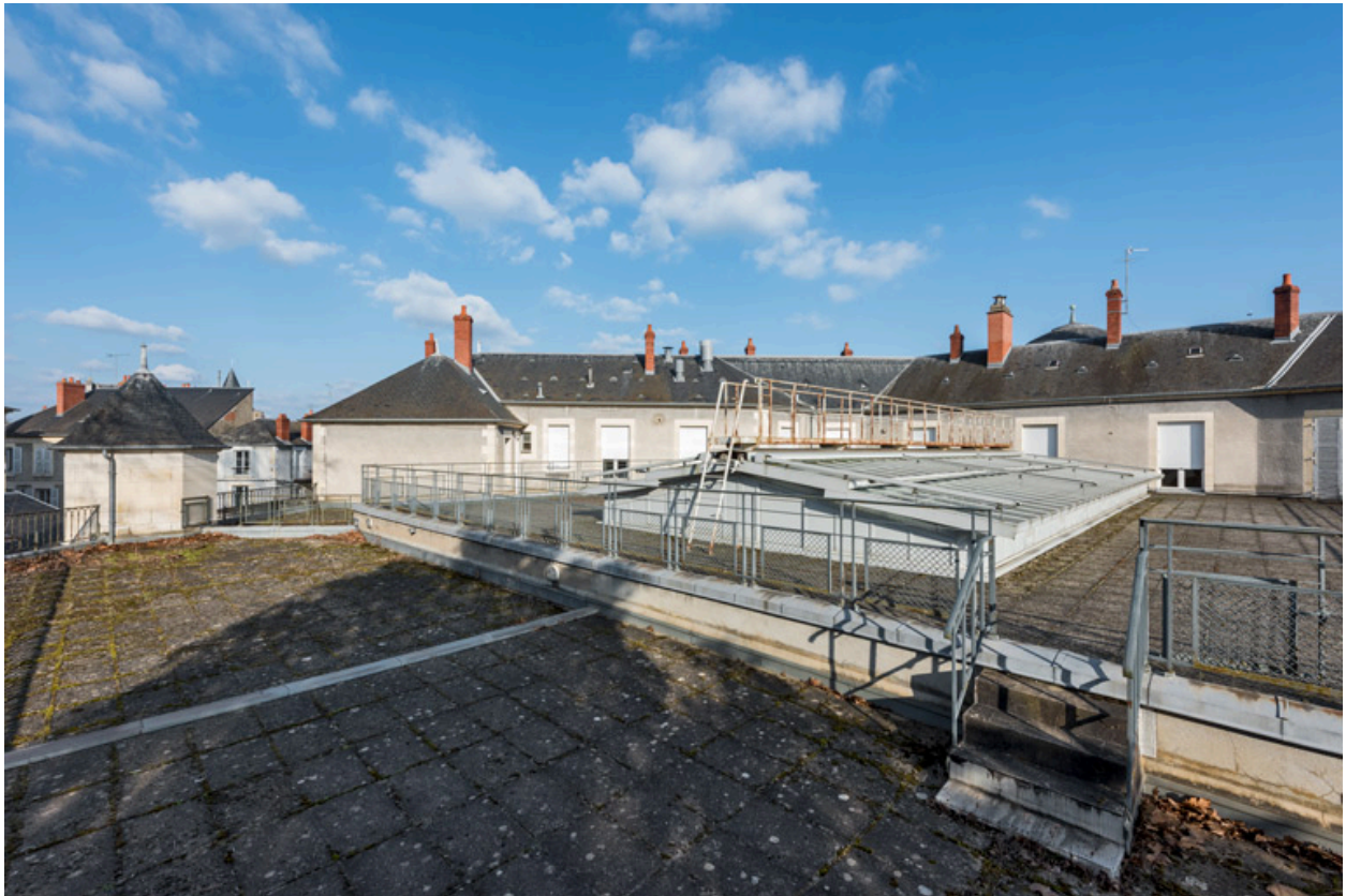
Verrière en toiture du hall du public.
