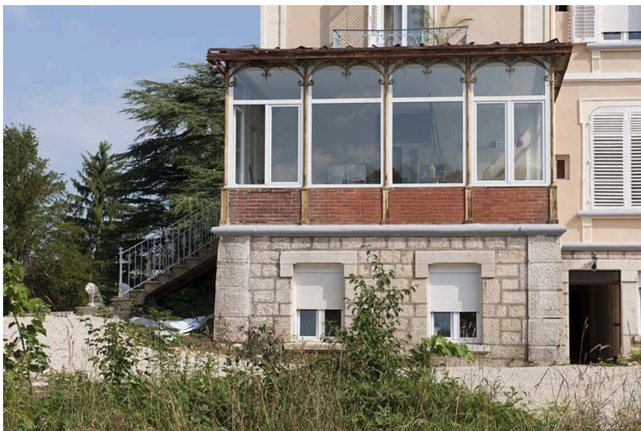
Détail de la véranda.
