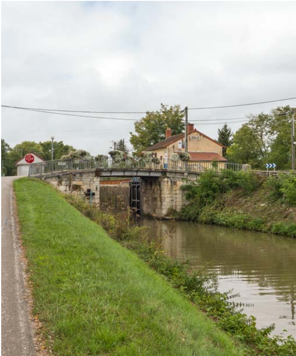
Vue d'ensemble du pont.
