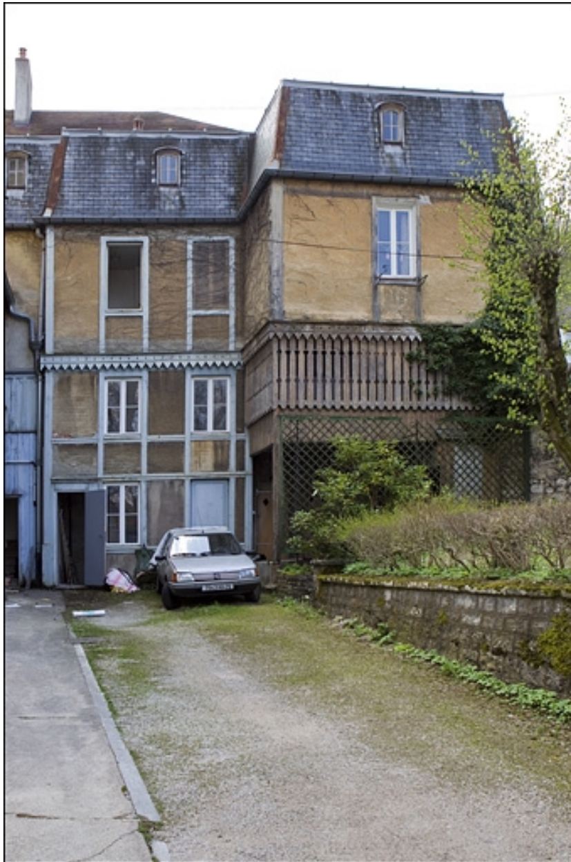
Détail de l'aile sur cour, de face.
